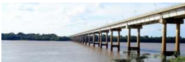
Figura 2: Ponte da Integração e CUF
