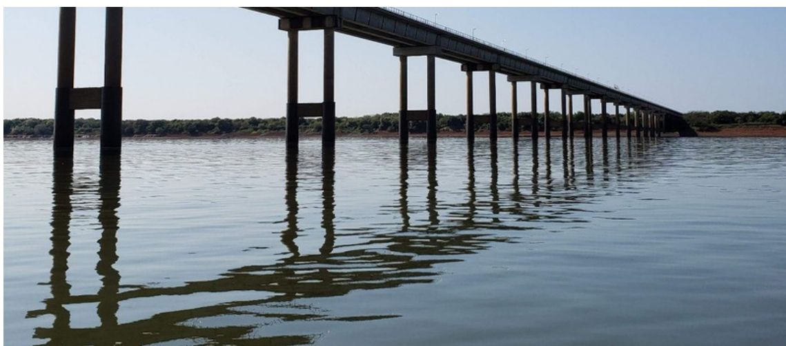
Foto: Ponte Internacional São Borja BR / Santo Tomé AR
