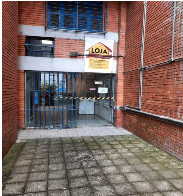
Figura 1 – Casa de Economia Solidária de Santana do Livramento
