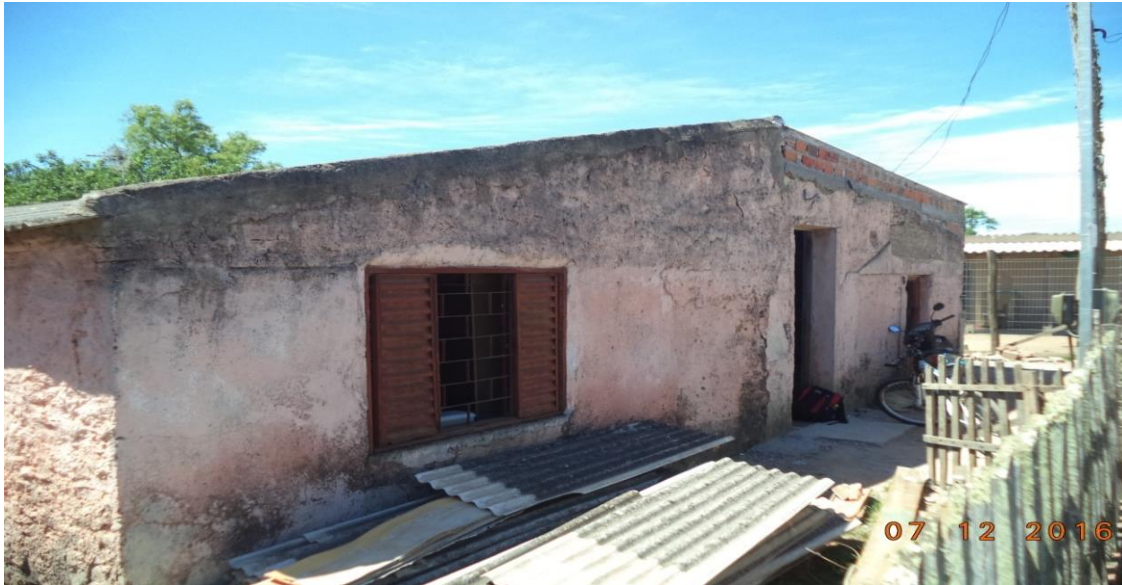
Foto 5: Fachada do antigo terreiro do Senhor Edi Localizado no Bairro Carvalho, no segundo corredor após a Rua Joaquim Caetano a esquerda da Rua João Pinto da Silva.
