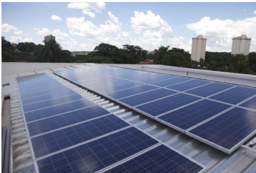
Figura 12: Células fotovoltaicas que transformam a radiação solar em corrente elétrica, que pode ser armazenada em baterias. (Extraído de: www.neosolar.com.br )
